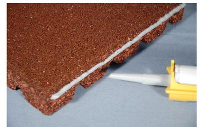
Legen Sie die erste Platte mit 2 Personen in eine Ecke Ihrer Fläche und drücken Sie die mit Klebstoff bedeckten Seiten vorsichtig gegen die Rahmenkonstruktion. Achten Sie darauf, dass Sie Ihren kompaktierten Unterbau nicht "beschädigen". Arbeiten Sie in dieser Weise weiter in einer Reihe. Bei der letzten Platte einer Reihe kann ein zuschneiden der Platte erforderlich werden. Der PU-Kleber ist für ca. 30 min. noch korrigierbar.
